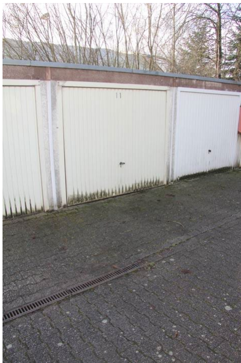
Garage zur Wohnung
