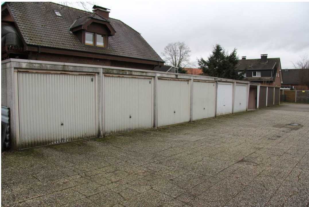
Garage im Innenhof
